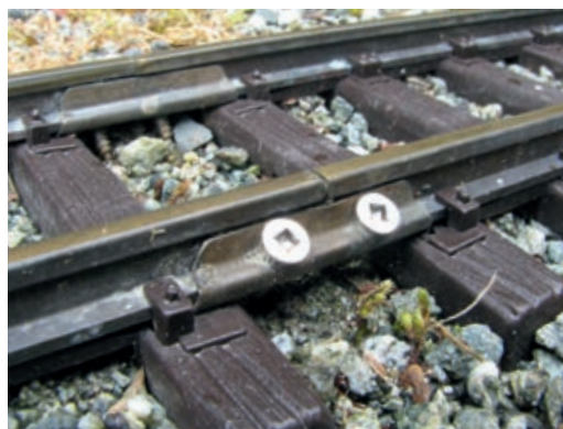
Die einfache Art Schienen zu verschrauben ist der Griff zu Blechschrauben, die durch die Laschenverbinder in vorgebohrte Löcher geschraubt werden.
