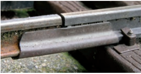
Gartenbahners Schreck: oxydierte und verschmutzte Laschenverbindungen sorgen für hohe Übergangswiderstände – bis irgendwann nichts mehr fährt.
